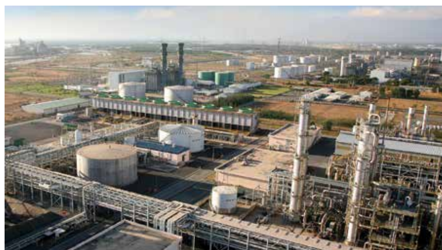
Nhà máy Đạm Phú Mỹ. Ảnh: PVFCCo
